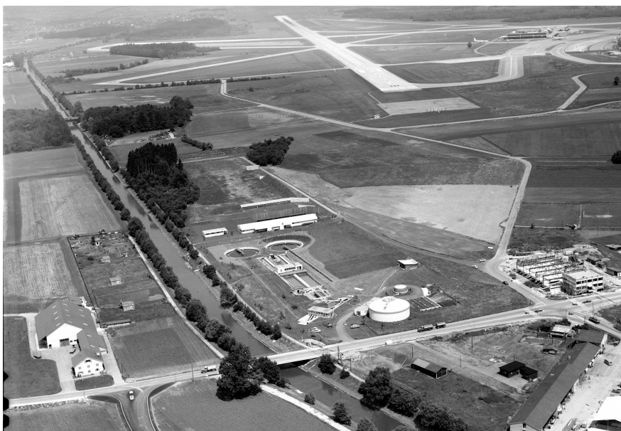
Abb. 5: Abwasserreinigungsanlage Kloten Opfikon und des Flughafens, 1965.
