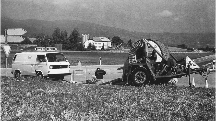
Abb. 5: Einziehen von Glasfasern, irgendwo zwischen Bern und Neuchâtel.
