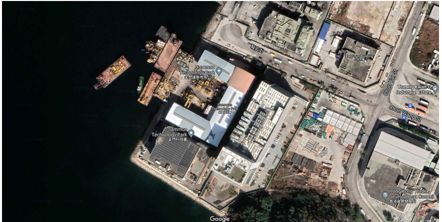
Abb. 5: In Hong Kongs Tseung Kwan O-Industriedistrikt stehen nahe der Landestation eines Tiefseekabels über ein Dutzend Rechenzentren. Das Gebäude rechts neben dem Technologiepark ist ein Rechenzentrum der China Unicom, gemäss dem Unternehmen das erste und grösste in Übersee.
